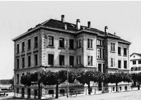
Sekundarschulhaus (links), Pausenplatz mit Turnhalle (rechts), 1950.
