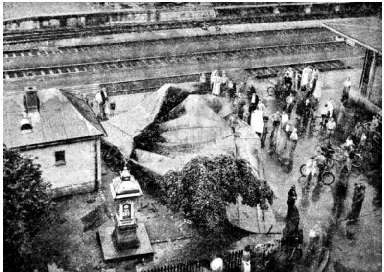
Ein orkanartiger Sturm löste das Blechdach auf dem Saal- anbau des Hotels Meierhof und trug es auf den Platz zwischen Bahnhof und Bahnhofabort, Bild im Anzeiger des Bezirks Horgen, 28. Juli 1950.
