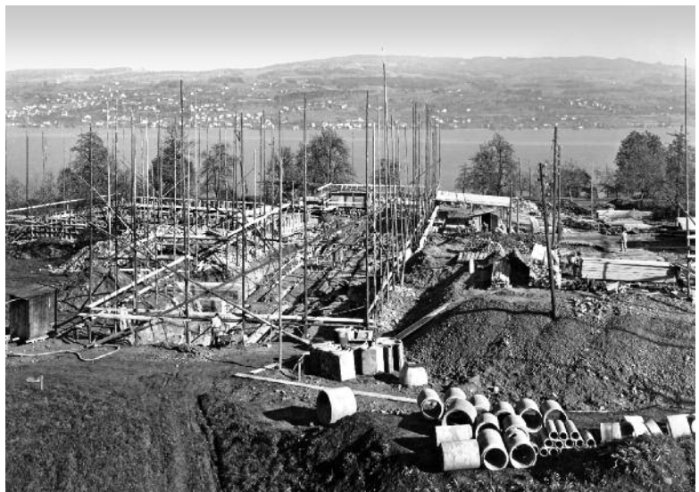
Bau des Sekundarschulhauses Berghalden (1952 eingeweiht).
