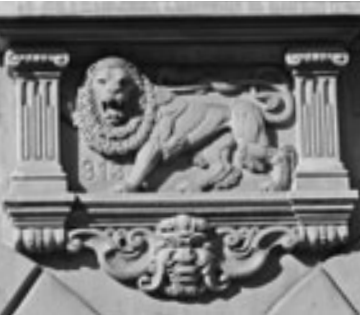
Detail Fassade ehemaliges Bank- und Postgebäude (Seestrasse 159), erbaut 1913. Der Löwe erinnert an den Vorgängerbau, das einstige Gasthaus zum Löwen.
