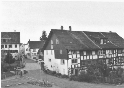
Der Gebäudekomplex «Kloster»
