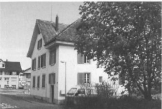
7 Altes Schulhaus Käpfnach
