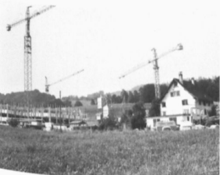
Bau mit Rüteli
