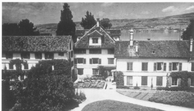
Stapferheim mit Badehaus (links) und ehemaligem Fabrikationsgebäude (rechts), um 1940
