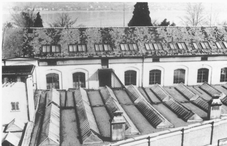
Seidenfabrik Stünzi: Dach der Shedhalle vor dem Abbruch 1949
