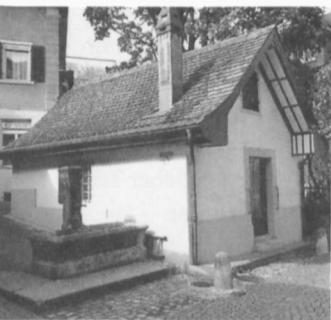
Das bald 200-jährige Waschhaus an der Neudorfstrasse 13, Aufnahme 1997
