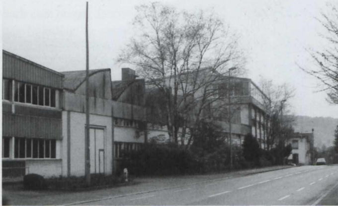
Firma Stäubli an der Seestrasse
