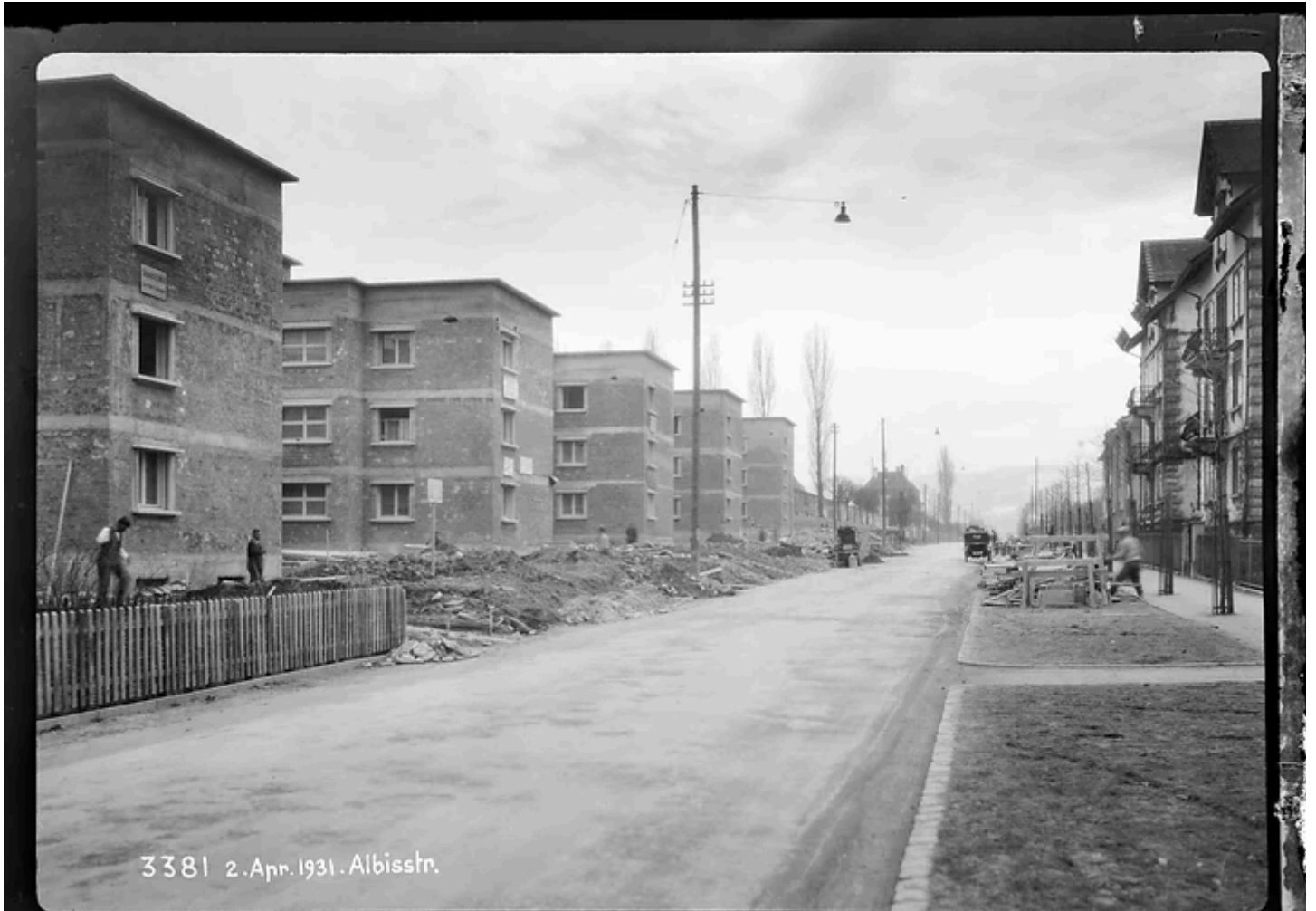
Wohnblöcke Albisstrasse 153-161 im Bau. 1931. Tiefbauamt. BAZ.
