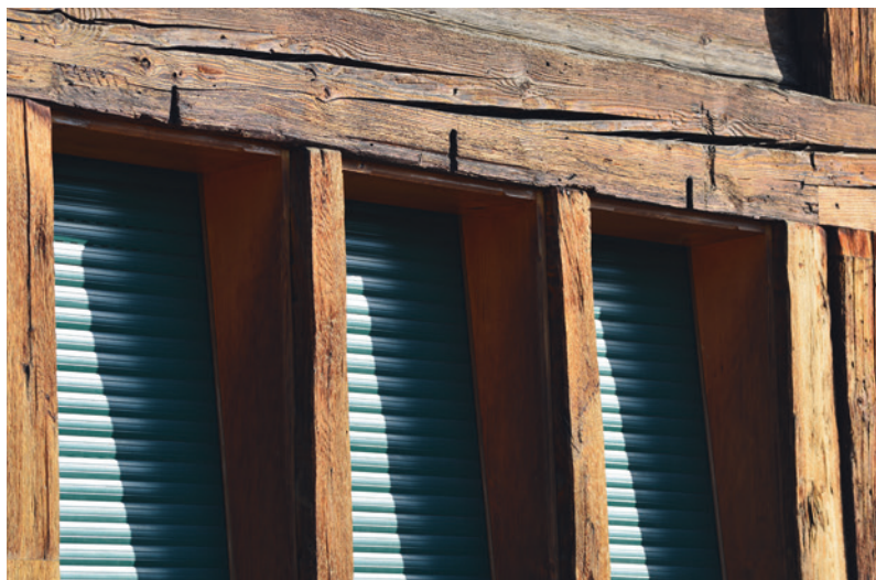
Vierteiliges Reihenfenster. Die ehemaligen Fallläden wurden mit einer durch die Schlitz über den Fenstern geführten Schnur von der Stube aus bedient.
