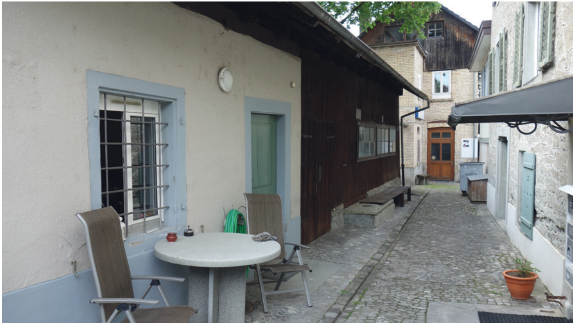
Unten: 1825 als Schopf errichtetes Nebengebäude mit Waschhaus, 2018.
