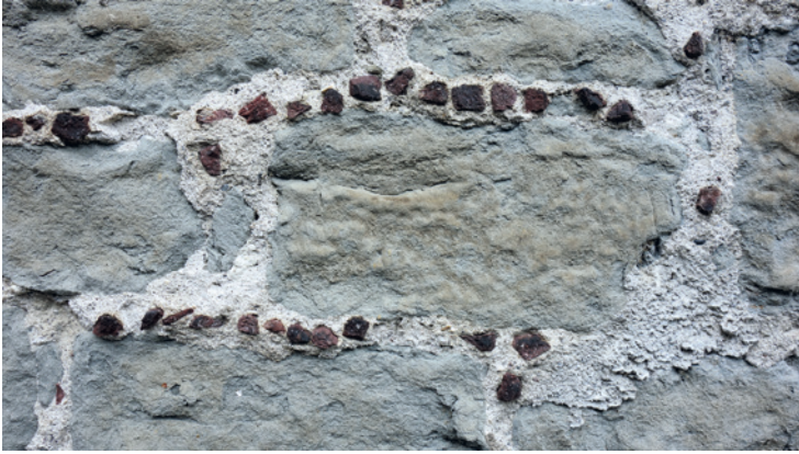
Oben: Mauerwerk- Verzierungen mit Sernifitsteinen.
