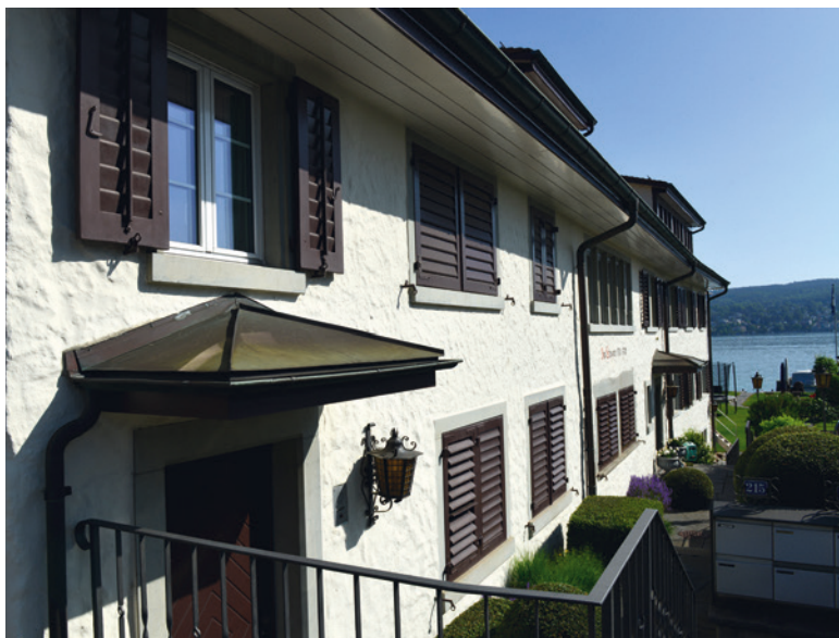
Oben: Südostfassade vor der Renovation von 1976.
