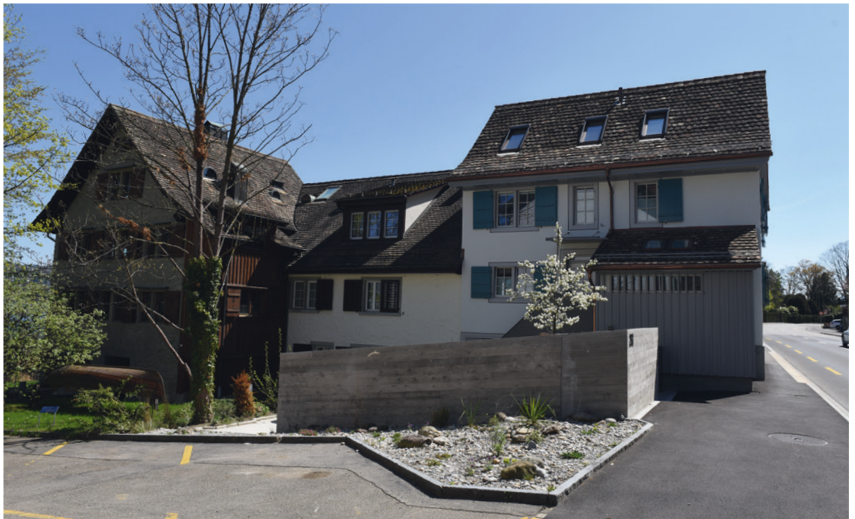
Unten: Ansicht von Nordwesten, 2018.
