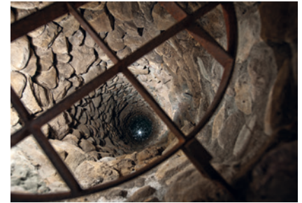
Schacht des Sodbrunnens, 17. Jahrhundert, Sanatorium Kilchberg
