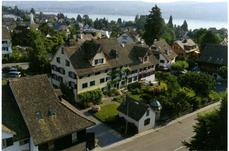
(Abb. 6) Blick vom Kirchturm auf die Baugruppe «Hof», 2015
