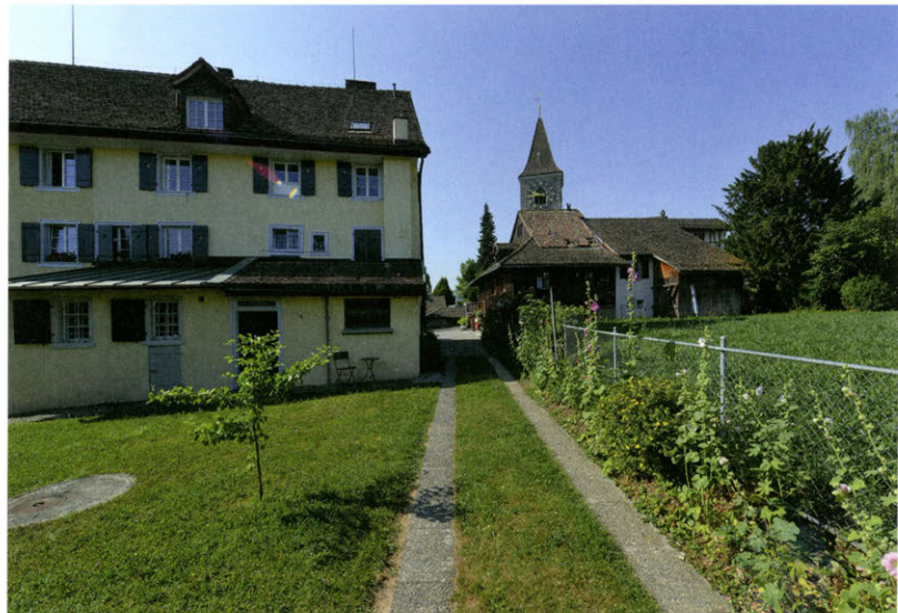
(Abb. 14) Blick auf die Rückseite des «Meierhofs» mit den ehemaligen Schweineställen, 2015
