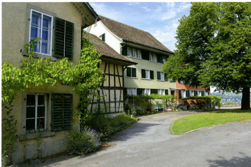
(Abb. 40) Baugruppe Dorfstrasse 80 bis 84 von Westen, 2015
