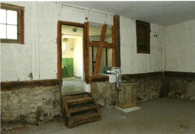
(Abb. 45) Westlicher Teil der ehemaligen Trotte, 2015
