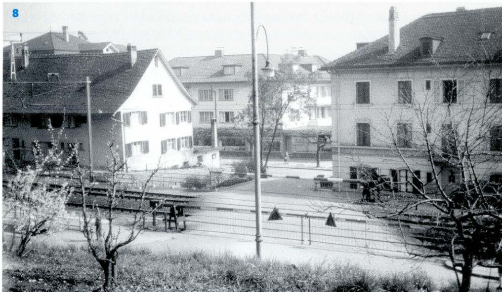
8 Blick über den 1960 aufgehobenen Niveauübergang zur Bahnhofstrasse (Seite 21).
