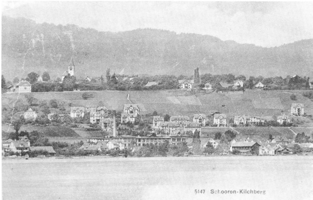
Kilchberg 1910. Am See die zehn Jahre früher fertiggestellte Schokoladefabrik, und zwar in unmittelbarer Nähe der früheren Fayence-Manufaktur im 18. und 19. Jahrhundert. Industriebetriebe wurden immer direkt am Seeufer erstellt. Links oben die Kirche, die schliesslich dem Dorf den heutigen Namen gab.
