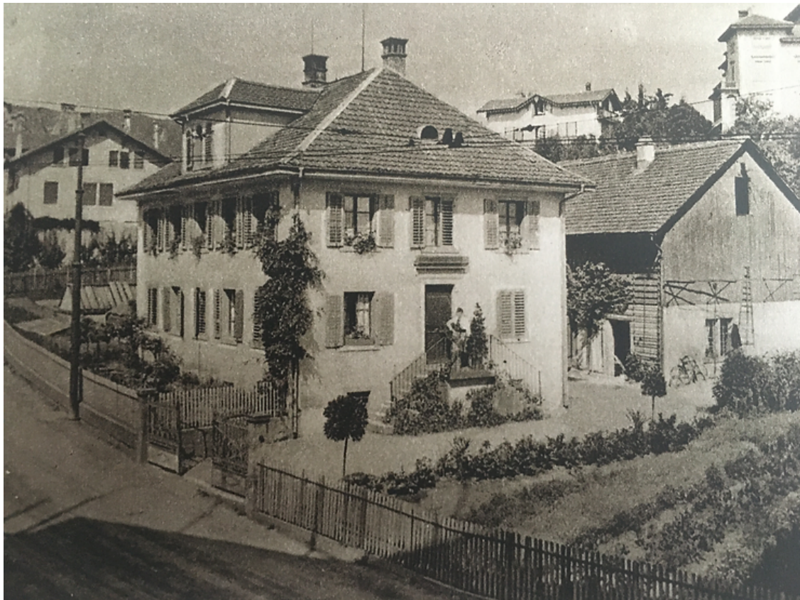
Doktorhaus Sonnental (Dr. Heinrich Baumann). Erbaut 1834, abgerissen 1915.
