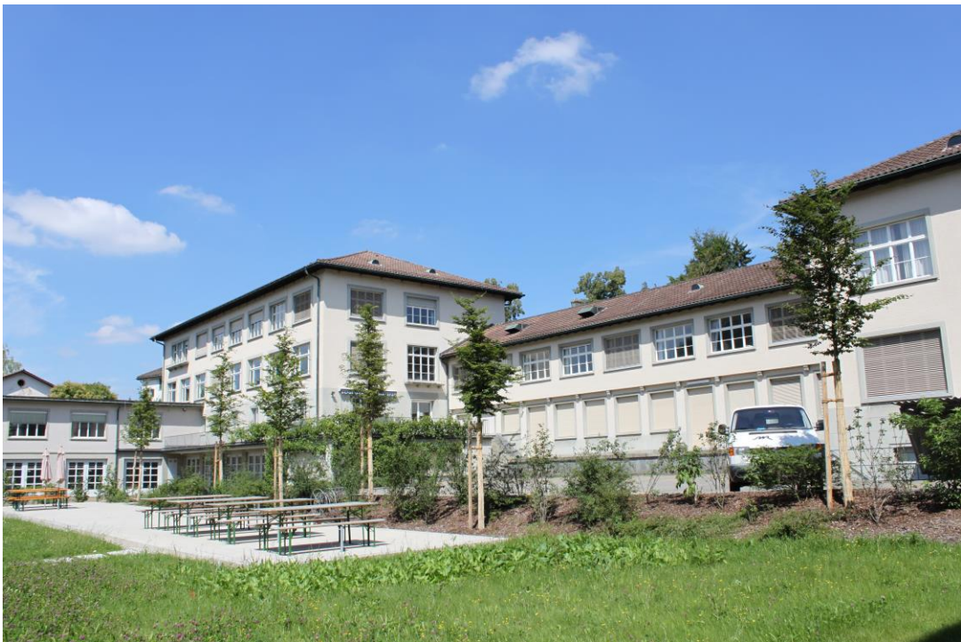
[→Abbildungen oben: Gemeindehaus, Bergstrasse 20]
