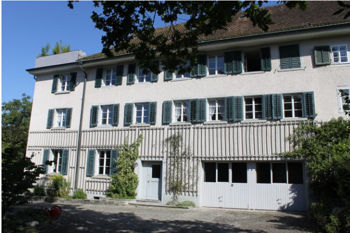
Oberdorfstrasse 12–14, Gebäude von S aus
