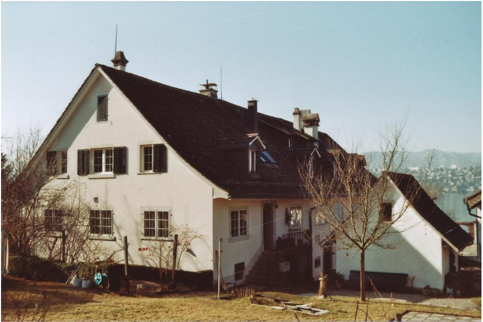
Der Vordere Gugger von NE: Hausteil Seestrasse 125 und Waschwäuschen
