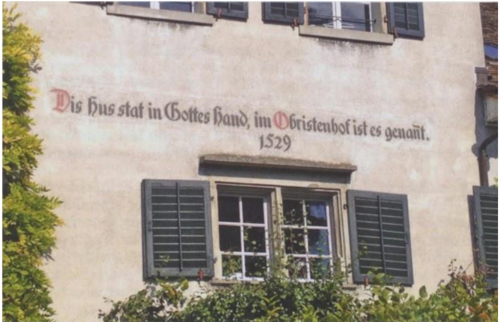
Der Obristenhof, Oberdorfstrasse 19
