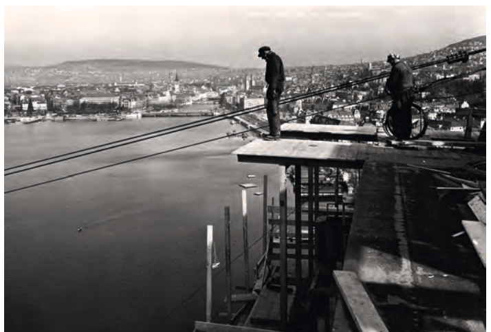
Montagearbeiten am Turm der Schwebbahn am rechten Seeufer
