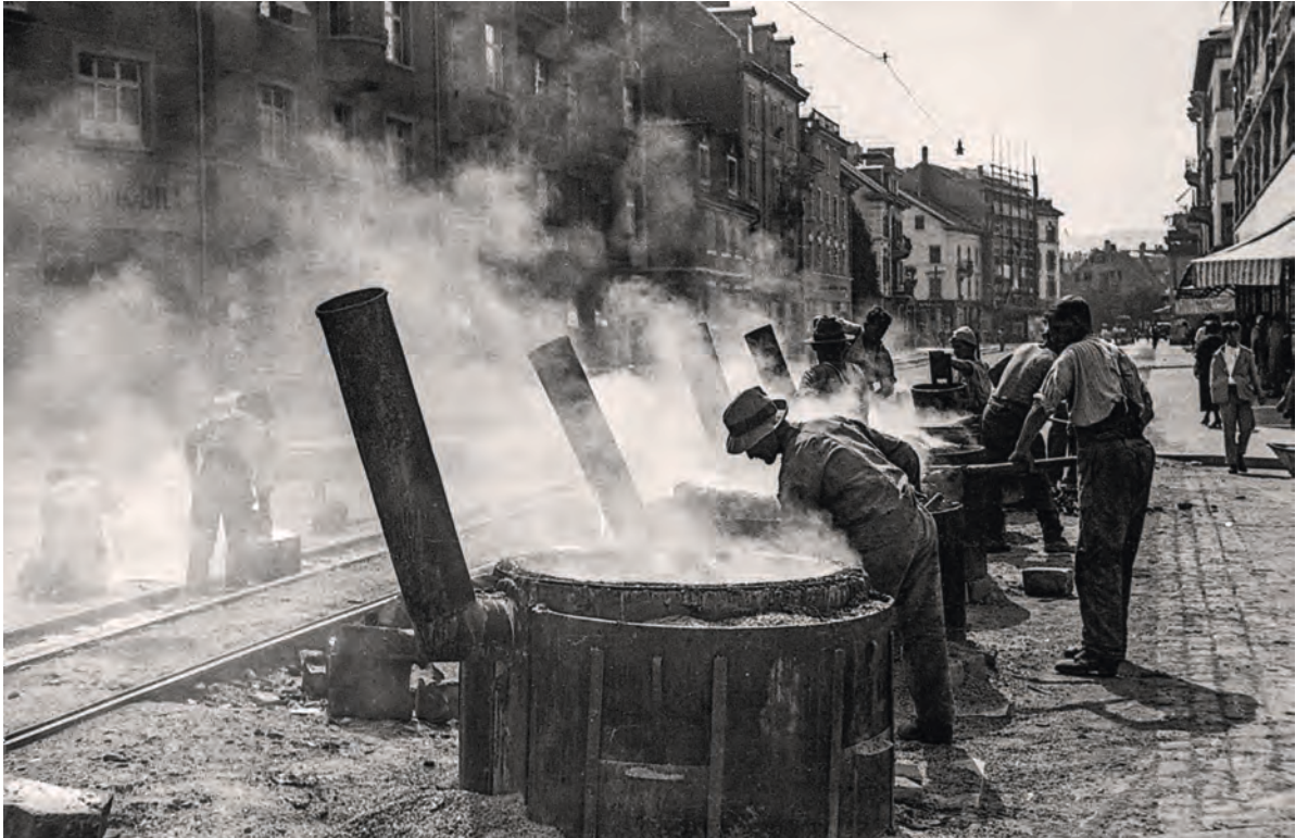
Teerkocher bei Strassen- und Gleisarbeiten an der Badenerstrasse, ca. 1930 (Foto: Emil Acklin)
