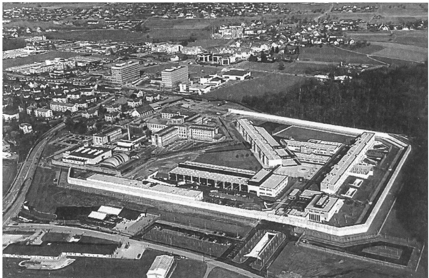
Neubau Pöschwies vor dem Abbruch der alten Anstalt – 1994
