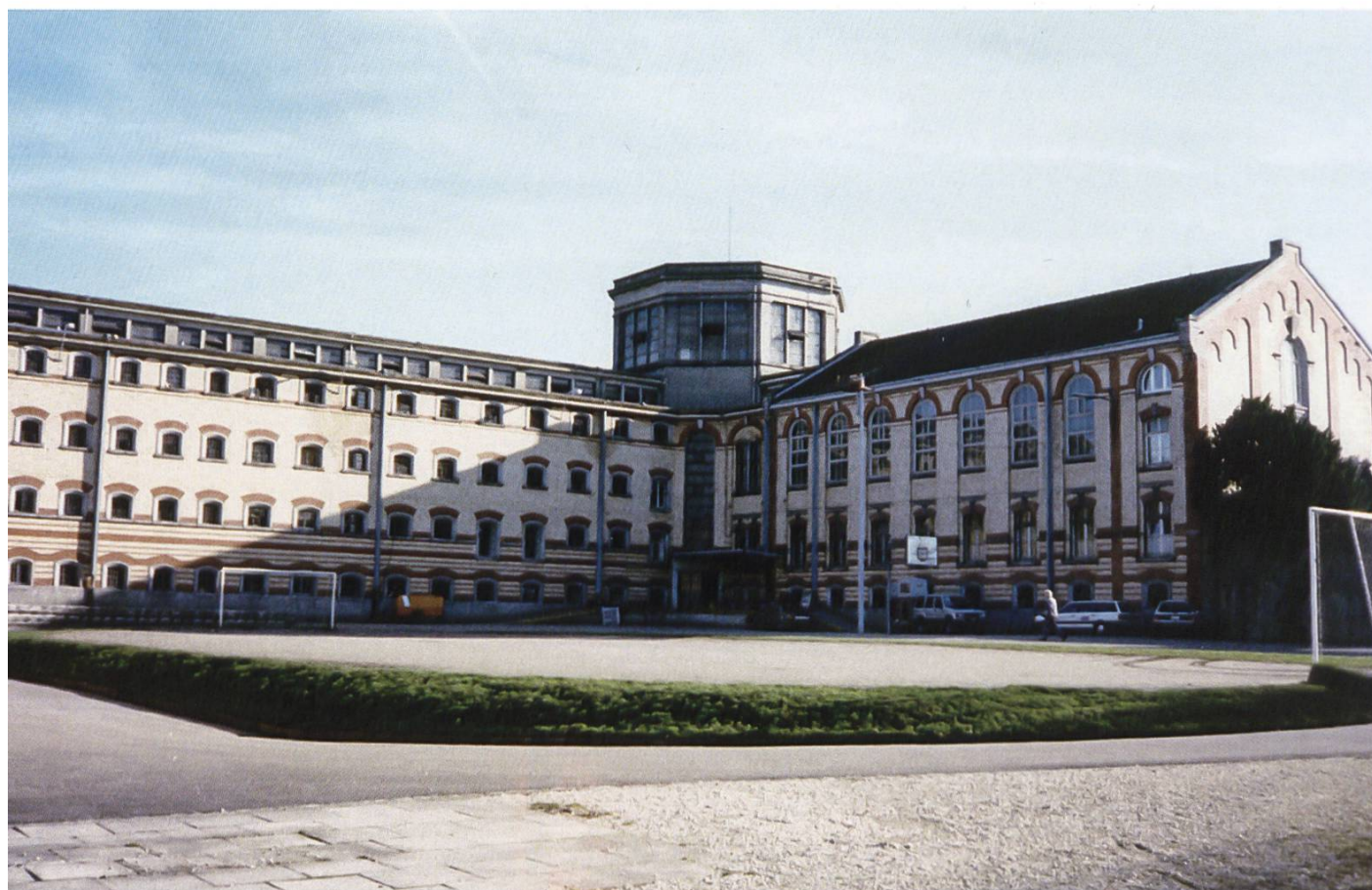
Flügelbau der alten Strafanstalt Regensdorf
