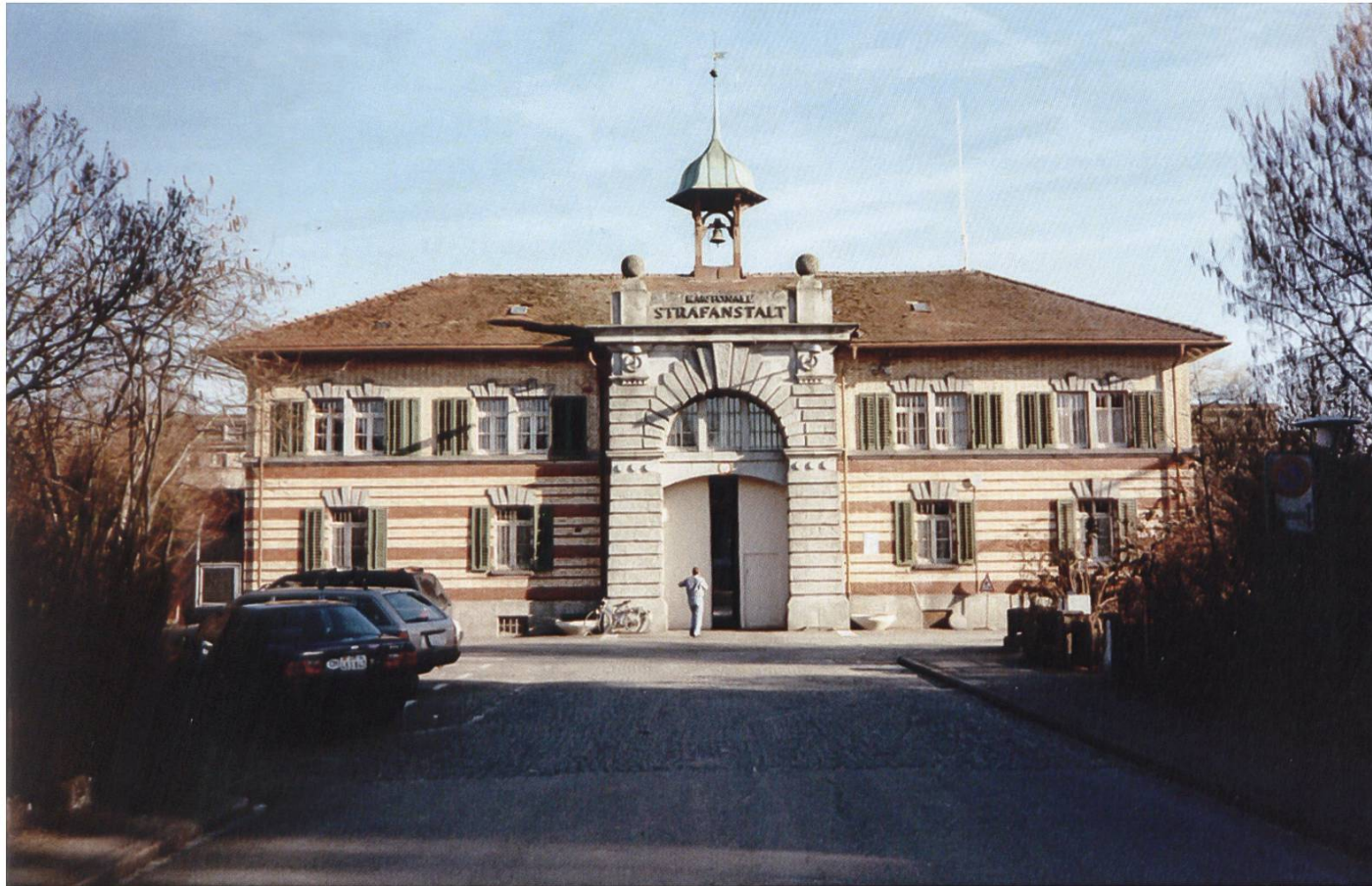
Torbau der alten Strafanstalt Regensdorf
