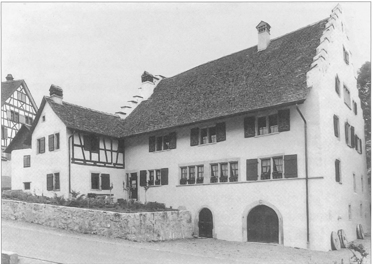
Bild 11: Renovierte Mühle 1970, Blick aus Süden
