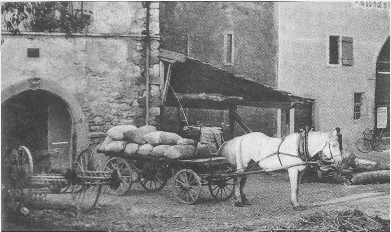
Bild 2: Anlieferung von Getreide vor Mahlraum, Bild ca. 1910.
