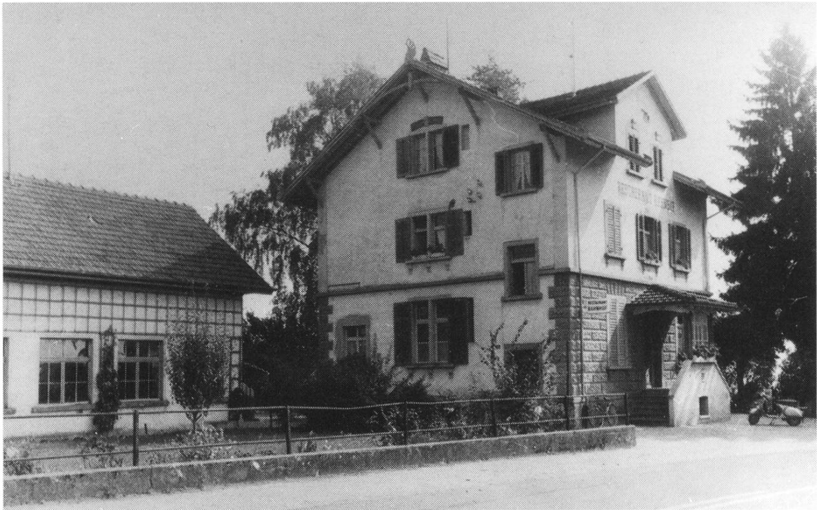
Restaurant Bahnhof, Otelfingen, gebaut 1908 durch J. Schlatter
