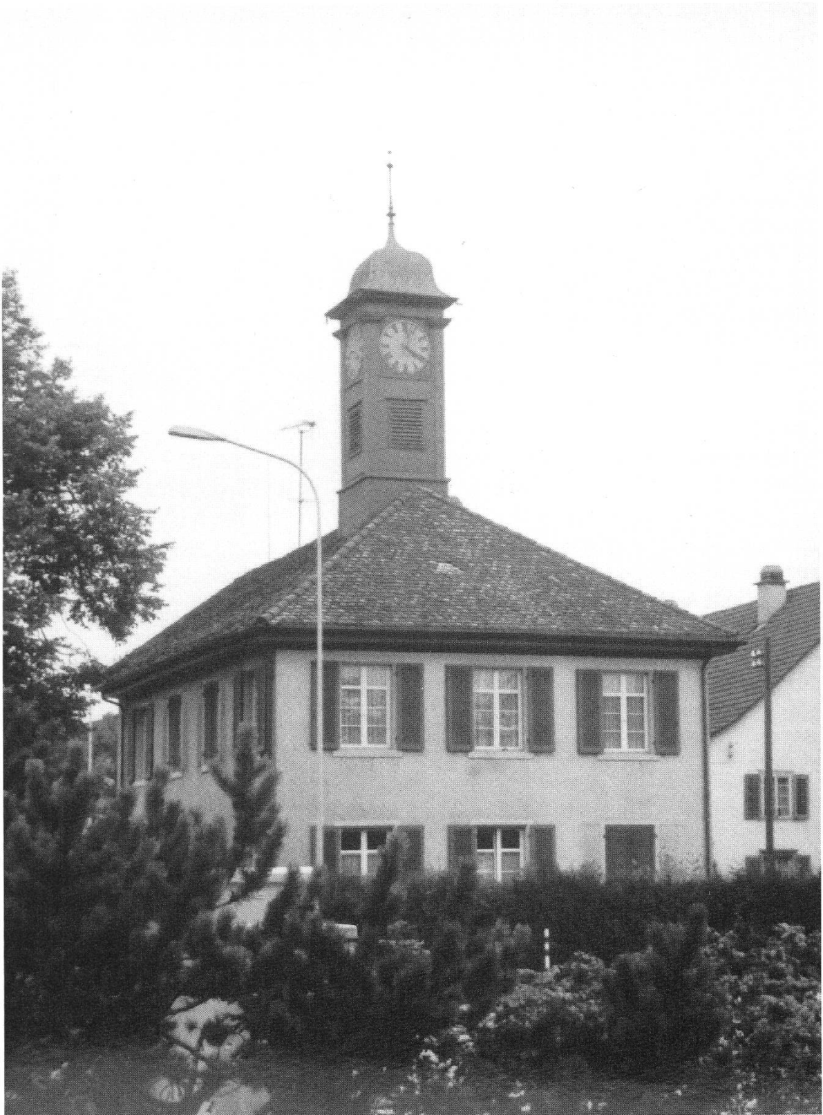
Altes Schulhaus beim Dorfplatz. Erbaut 1833/34
