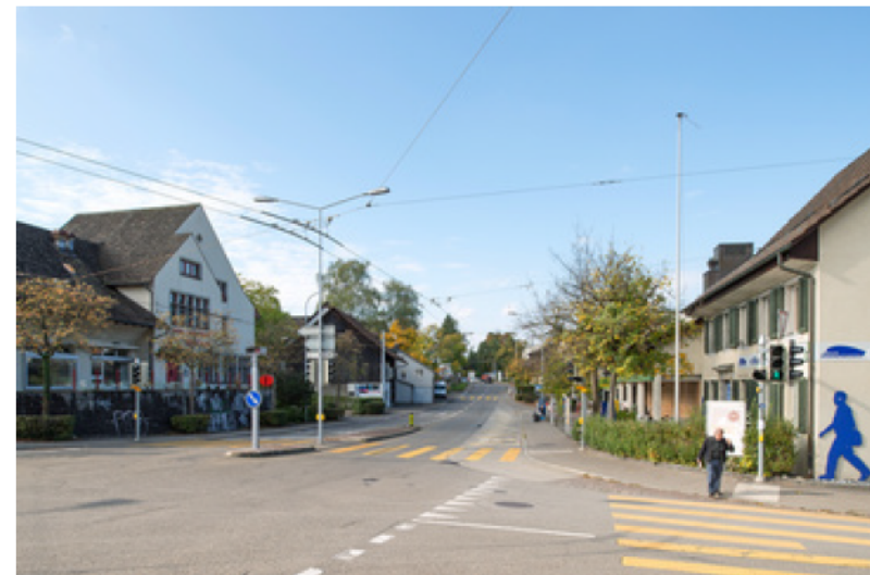
Hauptverkehrsachse vor der Sanierung: Witikonstrasse 2017 (Bild: HAL_007829, Juliet Haller)
