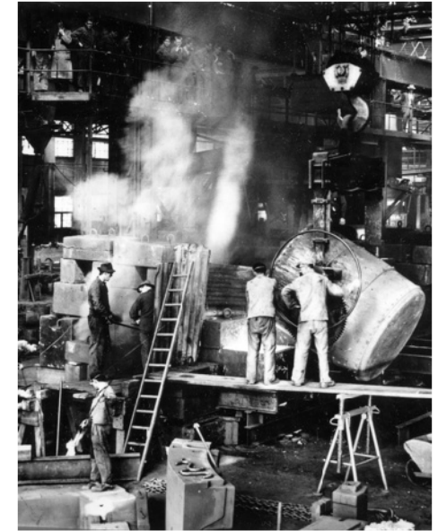
1895 im Quartier angesiedelt: Die Maschinenfabrik Escher Wyss (Bild: BAZ_161507)
