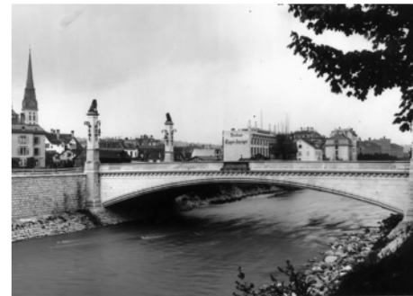
Die Stauffacherbrücke 1902, kurz nach ihrer Eröffnung (Bild: BAZ_086420, Breitingner)
