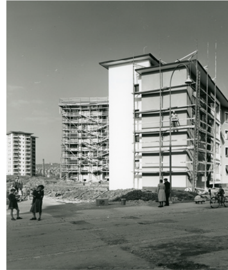
Heiligfeld 1954: Die ersten Hochhäuser der Stadt im Bau (Bild: WOL_000476, Michael Wolgensinger)
