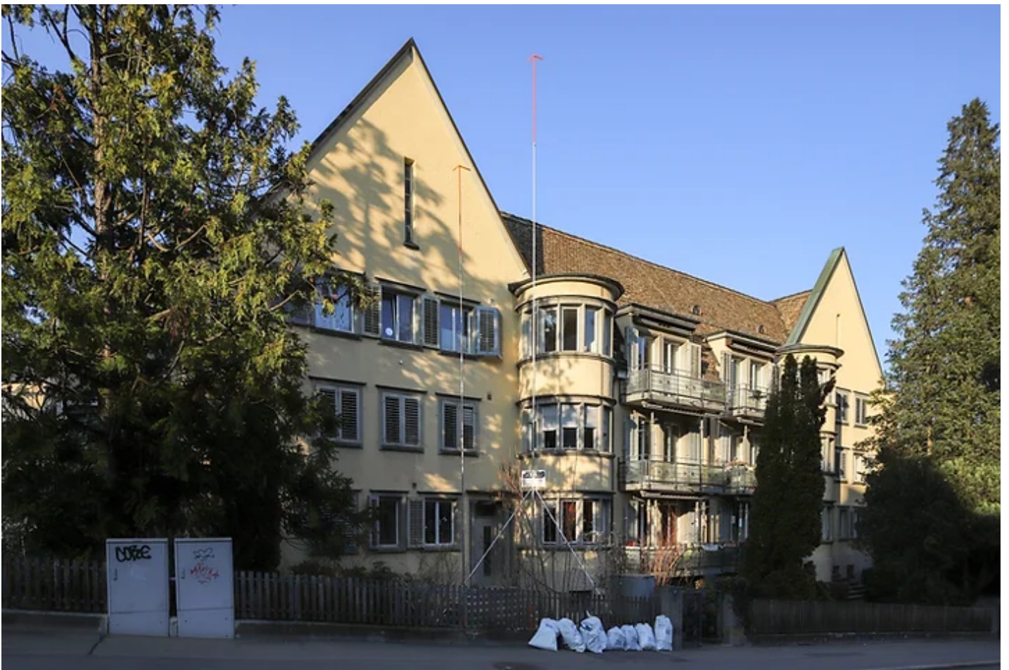
Morgentalstrasse 28-30. 2022. Foto: Wenger Timon. Baugeschichtliches Archiv Zürich.
