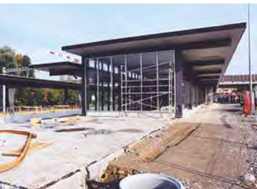
Die S-Bahn-Station Glanzenberg im Bau, 1999.
