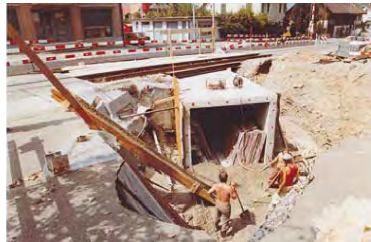
Ruggacker: Bau der Unterführung AGZ, 1983.
