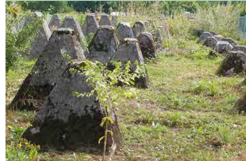
Panzersperren unterteilen die Anlage Vogelau.
