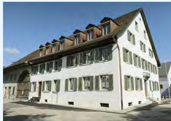
Der renovierte «Alte Bären» im Dietiker Ortskern.
