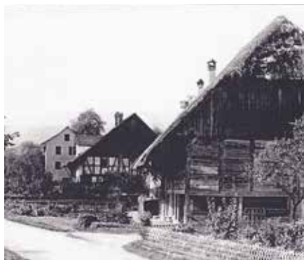
Das oberste Haus ist die «Heimat» an der Steinmüllistr. 60. Davor das 2006 abgerissene Bauernhaus Ungricht/Bräm. Unten das baufällige Bauernhaus mit dem Café Spalt oder Café Schlauch an der Bergstrasse.
