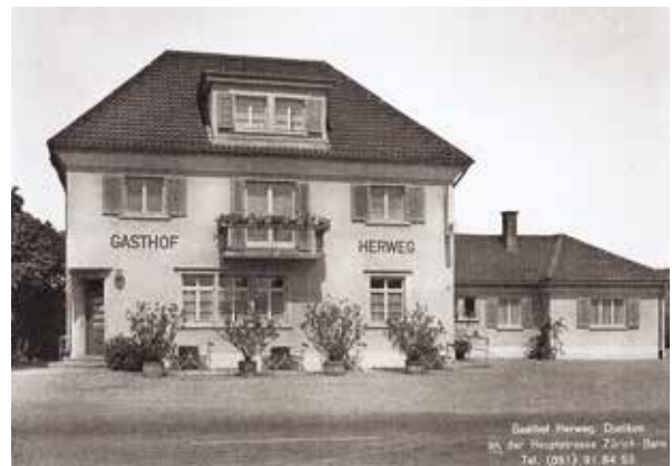
Der neue «Herweg» von 1933 mit dem Anbau von 1949.
