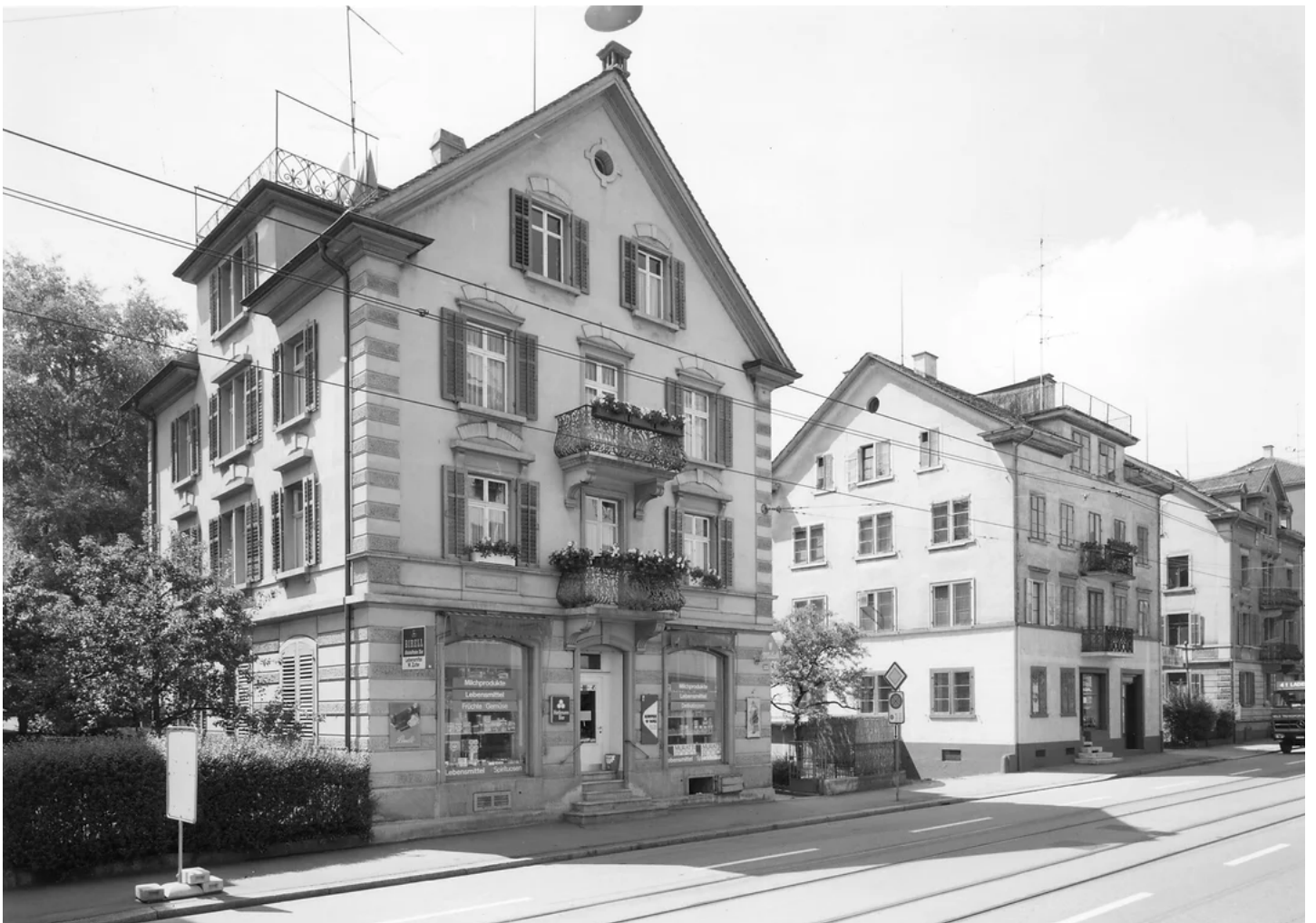
Drei Baumeisterhäuser an der Seestrasse (320, 324, 328). 1979. Baugeschichtliches Archiv Zürich.
