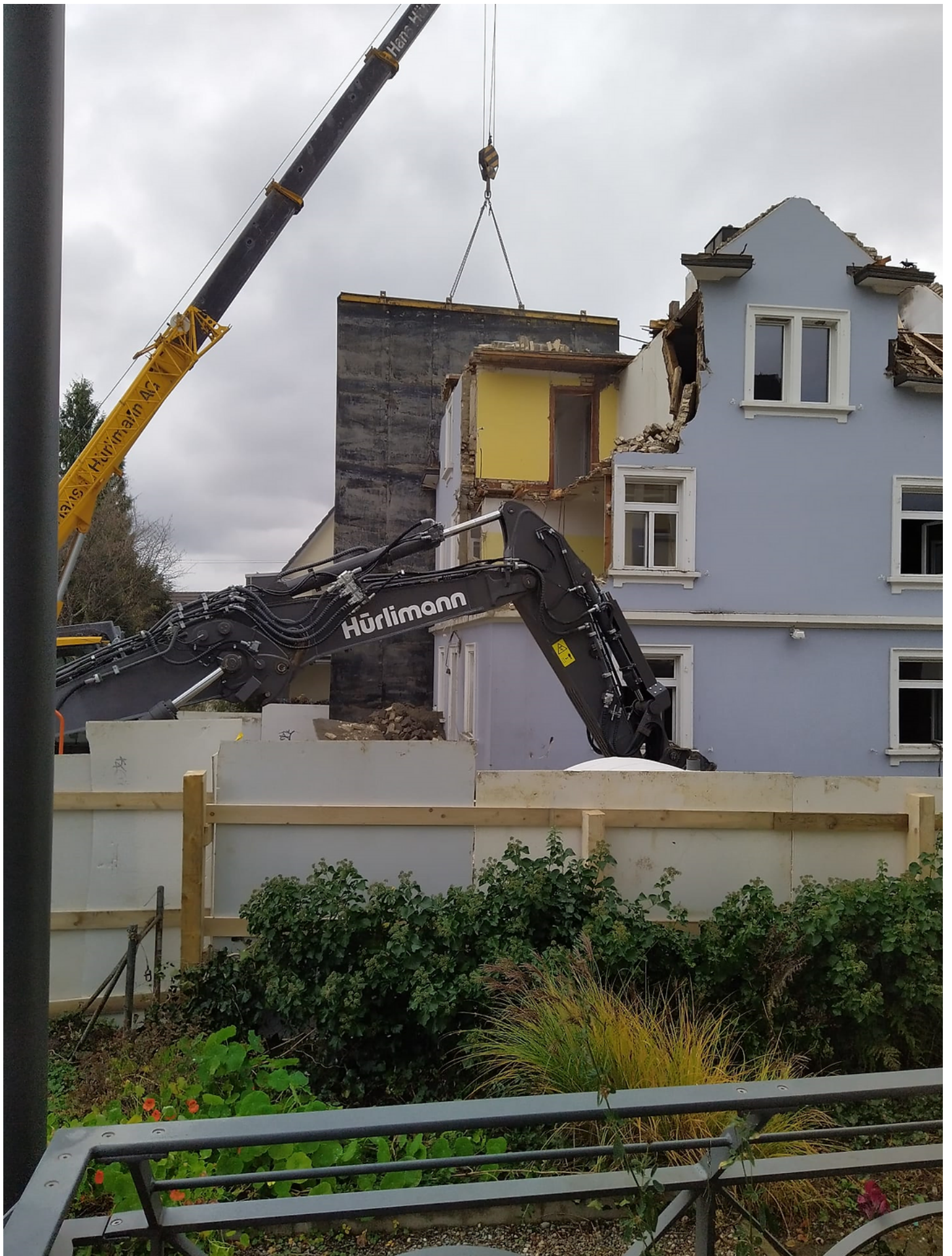
Simmlersteig 16 im Abriss. Aufgenommen am 5. Dezember 2022. Foto in Privatbesitz.
