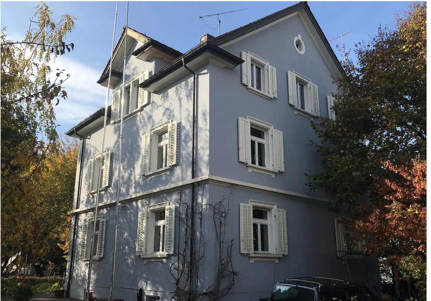
Bedroht: Baumeisterhaus Simmlersteig 16. Foto SB (29.10.2021).
