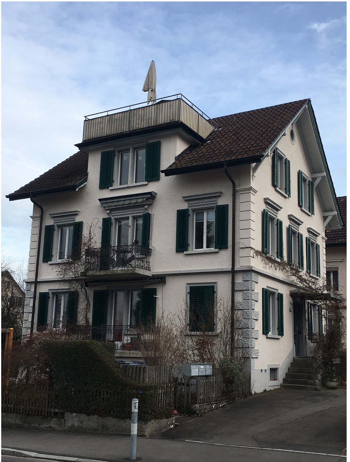
Baumeisterhaus Widmerstrasse 51. Foto SB (27.2.2022).
