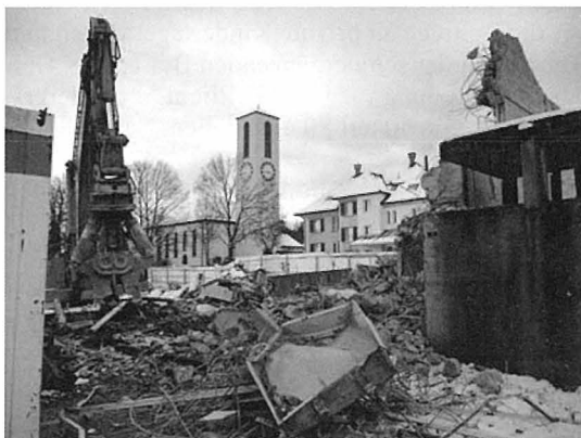
Die Alterswohnungen an der Bremgartnerstr. 39 sind abgebrochen.
