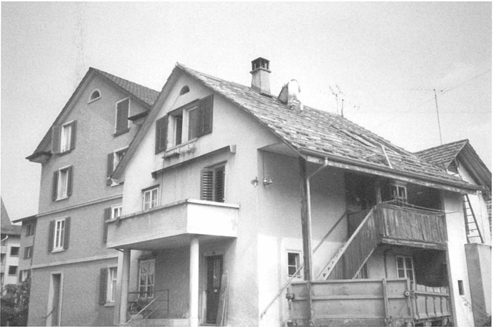
Das Haus rechts wurde 1983 abgerissen und wies am Kellereingang einen sog. Kreuzstock von 1648 auf.
