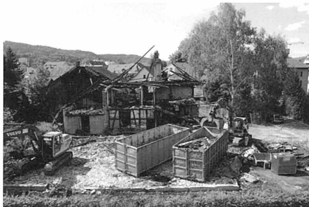
Die Brandtrümmer des Bauernhauses J. Ungricht an der Bühlstr. 8 werden abtransportiert.
