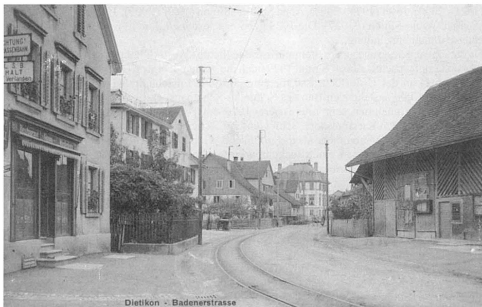
Links das Restaurant "Alpenrösli" der Familie Jakob Simon-Wiederkehr (gleichzeitig Haltestelle der Limmattal-Strassenbahn). In der Bildmitte das Restaurant Central, rechts die Scheune von Bäcker Frey (1909).
