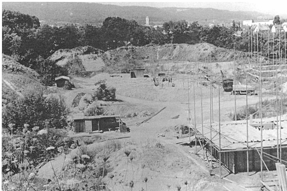
Die Siedlung Hofacker ist im Bau. Blick Richtung Westen (Foto 1945).
