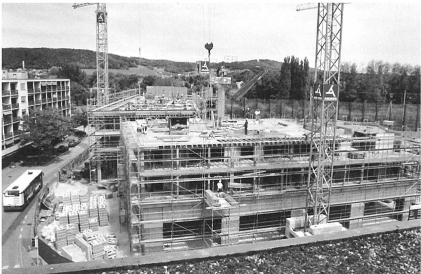
Auf dem Schellerareal an der Zürcherstrasse entsteht die Überbauung TRIO.
