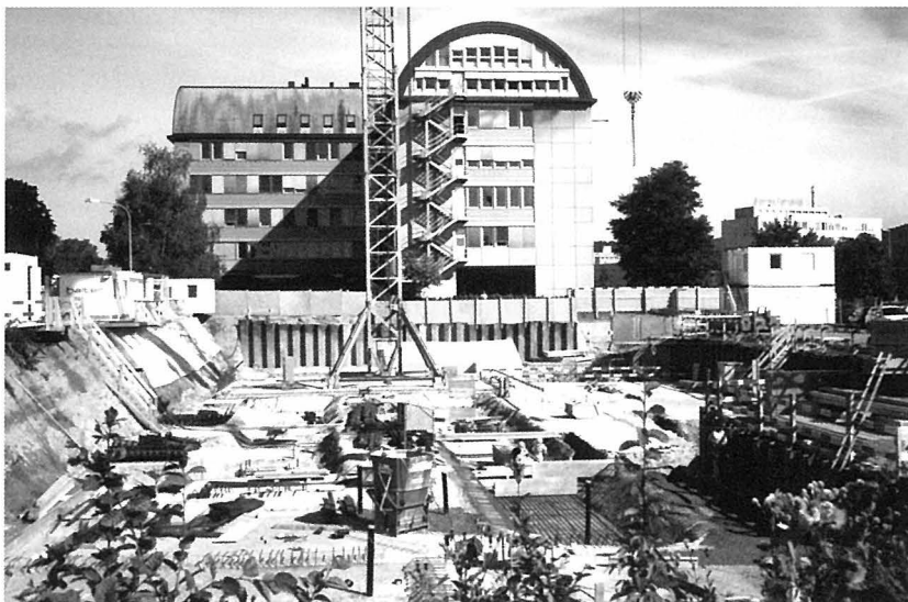
An der Neumattstrasse ist das Fundament für das Bezirksgebäude gelegt.
