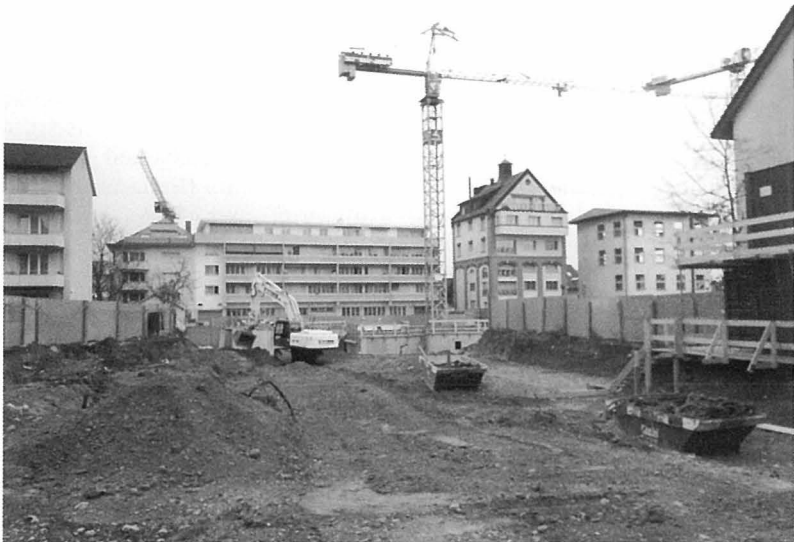
Die Gebäude der alten «Salami» müssen Wohn- und Geschäftshäusern weichen.
