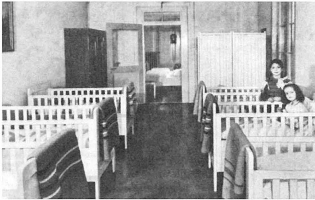
Schafsaal 1936. Der Schlafplatz der Schwester befand sich hinter einer Spanischen Wand.
