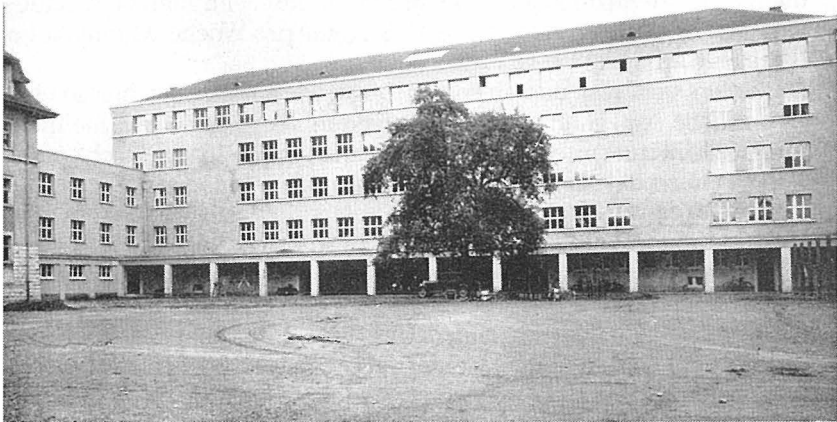
Der Anbau ist das sogenannte «Sekundarschulhaus»
