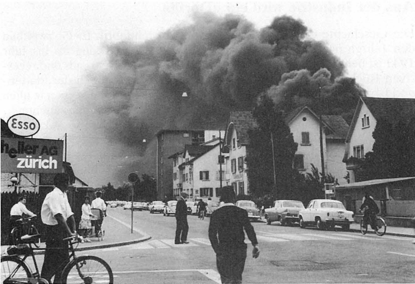
Grossbrand am 14. Juni 1964 (Muttertag). Ansicht der Rauchfahne von der Zürcherstrasse.
