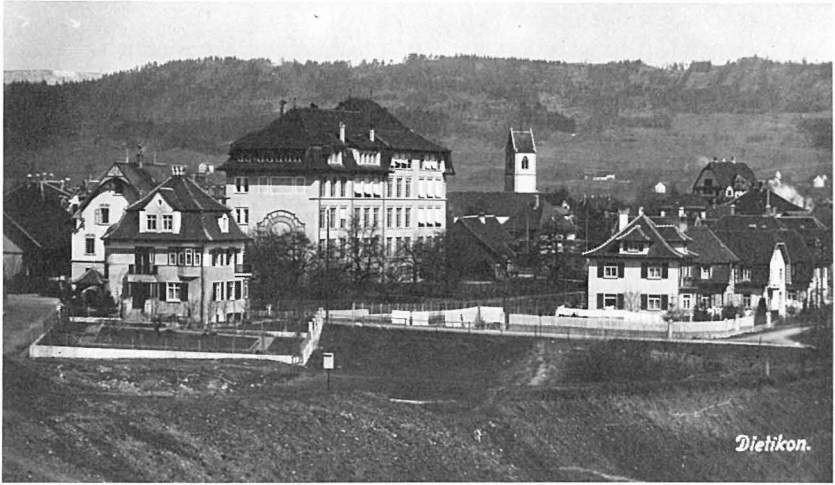
Der Erweiterungsbau des Zentralschulhauses konnte erst um 1930 verwirklicht werden, weil vorher beide Kirchgemeinden mit dem Neubau ihrer Gotteshäuser finanziell stark beansprucht waren. Die Einweihung fand 1932 statt. Im Hintergrund ist die neue katholische Kirche St. Agatha sichtbar, im Vordergrund die neugebaute Poststrasse.
