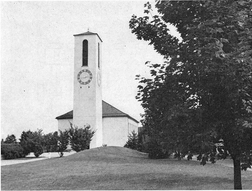
Ansicht der Kirche nach der Renovation, von der Bremgartnerstrasse her
