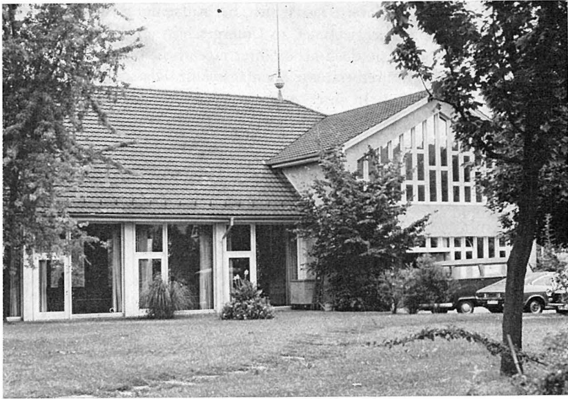
Reformiertes Kirchgemeindehaus, Ansicht von Nordosten
