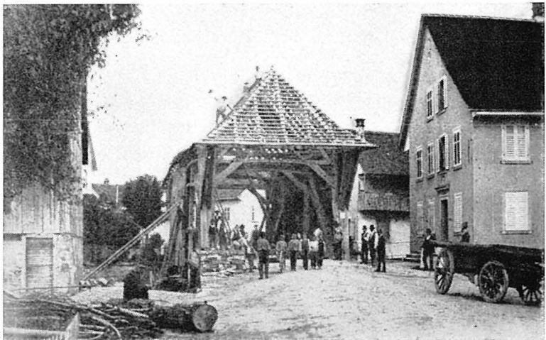
Abbruch der gedeckten Holzbrücke bei der «Krone» um 1895.
