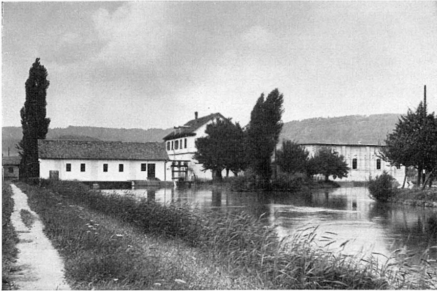
Bild 1. Die Maschinenhäuser des alten Werkes Dietikon vom Oberwasser aus gesehen. Rechts das im Jahr 1894 erstellte, 1932 außer Betrieb gesetzte und 1958 abgebrochene neuere Maschinenhaus. Das Giebelhaus in der Mitte enthielt ursprünglich eine Gasmotorenanlage als thermische Reserve. Später diente dieses Gebäude als Werkstätte. Links neben dem Giebelhaus die Einfahrt in die 1889 erstellte Schiffahrtsschleuse. Das quer im Kanal stehende niedrige Gebäude, das erste Maschinenhaus, wurde 1931 abgebrochen. Am Bildrand links erkennt man noch die niedrigen Shedbauten der Weberei Dietikon, die vom alten Werk aus über eine Transmission angetrieben wurde.
