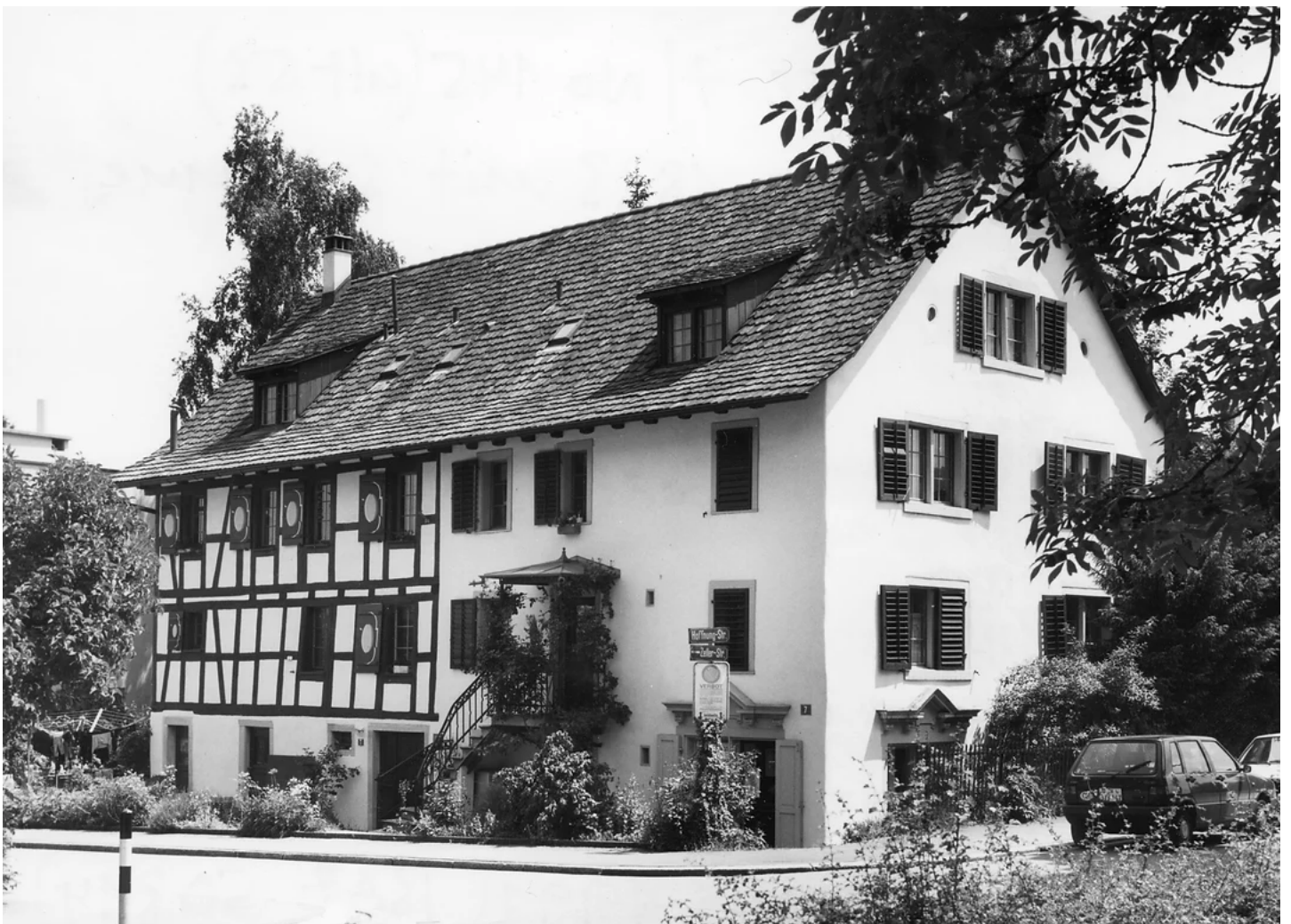
Haus zur Hoffnung. Hoffnungsstrasse 7, Wollishofen. 1991. Fotograf Erwin Küneni. Baugeschichtliches Archiv Zürich.
