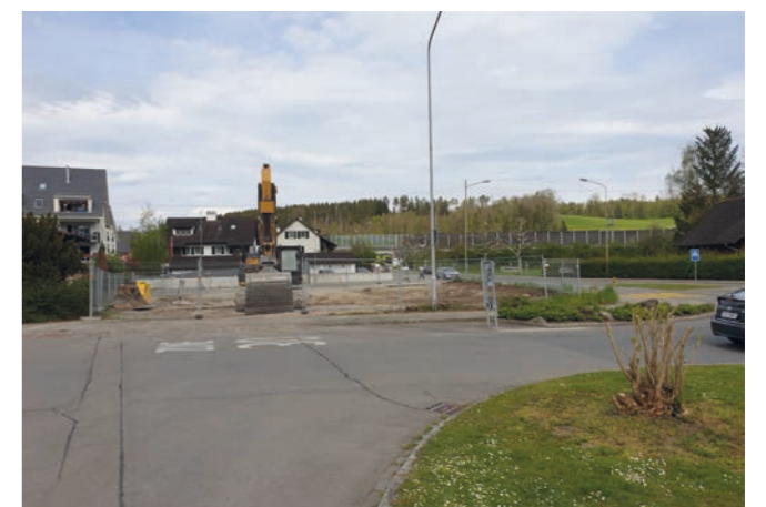
Oben: Knonau, Gasthof Adler mit Tanzsaal 2019. Mitte, unten: Nach dem Abbruch, April 2021. Bilder: ZVH
