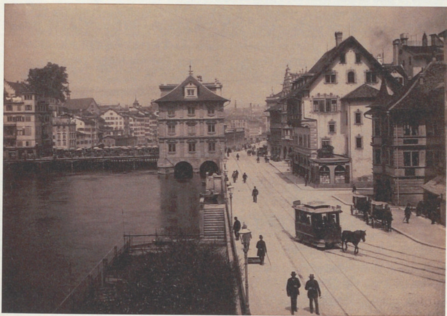
Rathausquai, Zürich, Fotografie, ca. 1890
