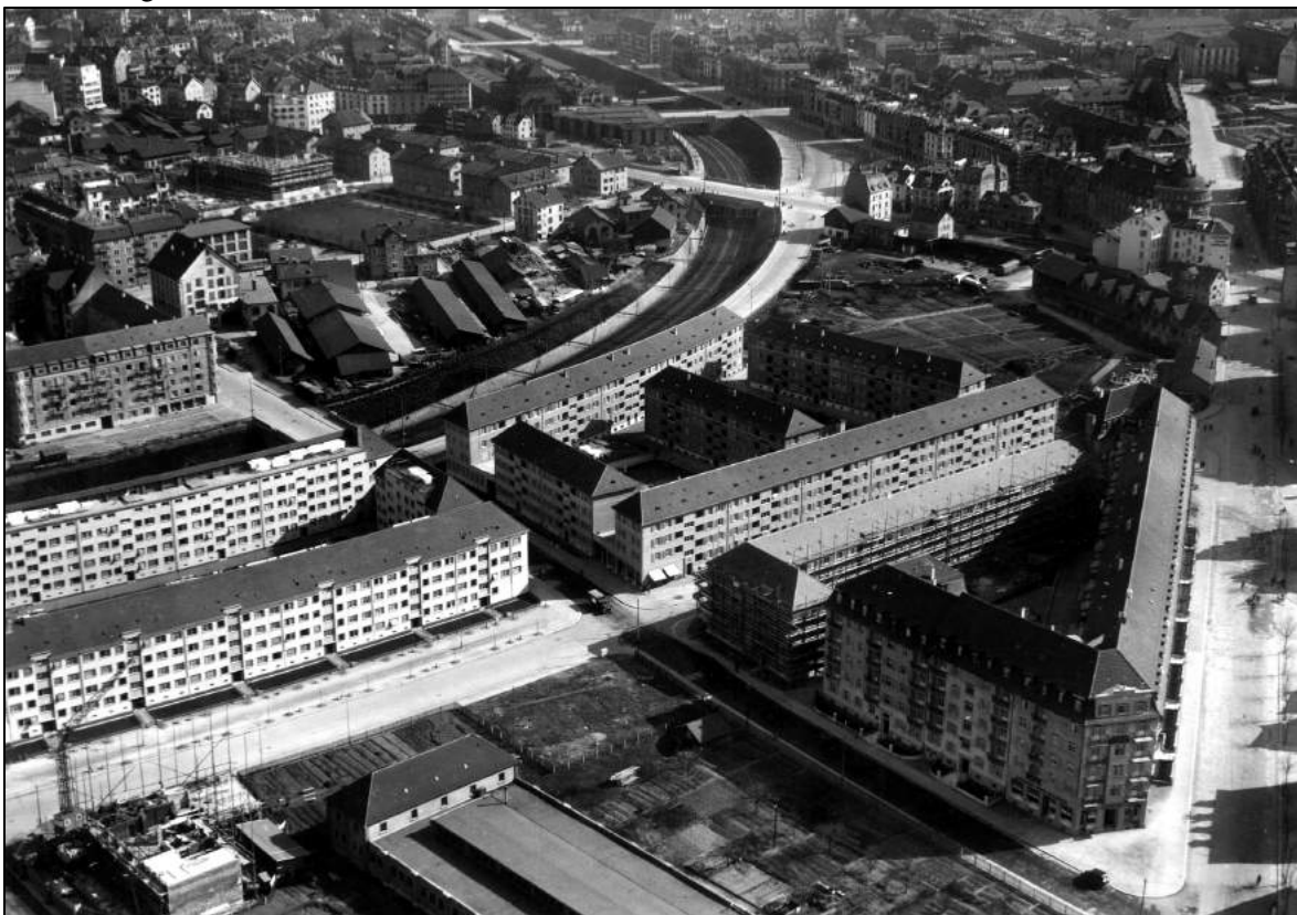
Siedlungen der Baugenossenschaft des Eidgenössischen Personals (links), der Allgemeinen Baugenossenschaft Zürich (rechts), der Gemeinnützigen Baugenossenschaft Röntgenhof (rechts im Vordergrund). Im Hintergrund die tiefergelegte Seebahn, Foto 1931, in: BAZ, Online Sammlung, https://baz.e-pics.ethz.ch [27. Juli 2018].
