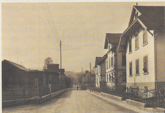
Kanzleistrasse: Gemeindestrasse ohne Asphalt
