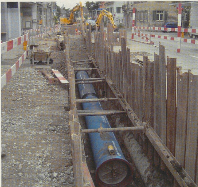
Erneuerung der Hauptwasserleitung Abschnitt Bollstrasse-Kanzleistrasse
