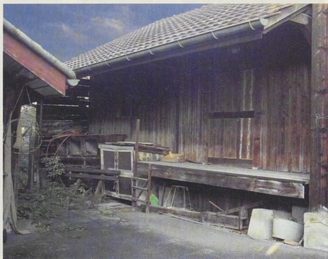
Rampe zur Mühle im Schopf
