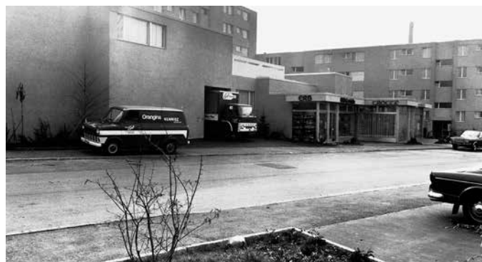
Das 1968 erbaute neue Betriebsgebäude mit dem 1972 eröffneten Restaurant Trotte.
