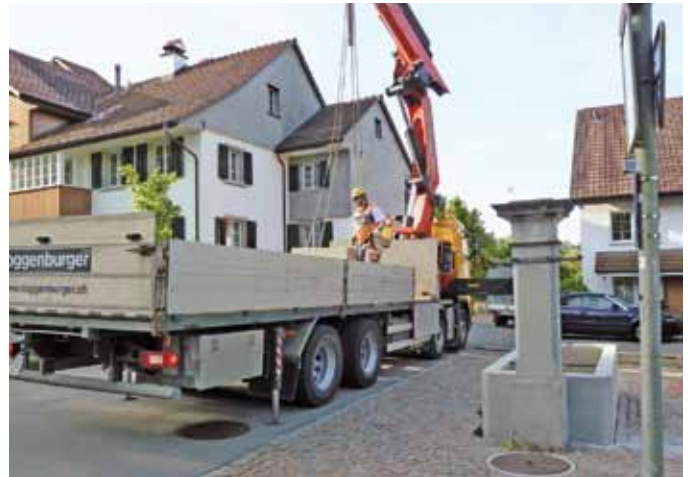
Mit einem schweren Kran erfolgte die Wiedermontage des erneuerten Brunnens.
