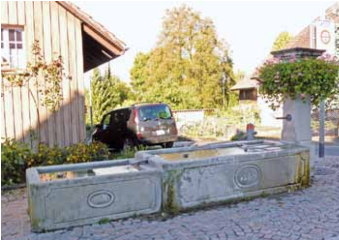
Unser lieber Oberseemer Dorfbrunnen von 1865 bei der alten Sennhütte hatte so gelitten dass er einer umfassenden Erneuerung bedurfte.
