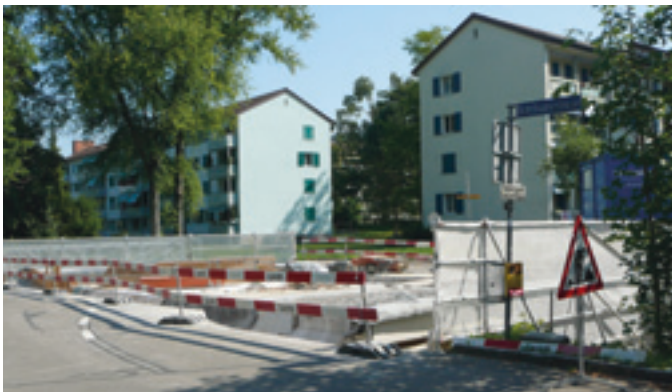
Sanierung der Brücke an der Oberseenerstrasse über den Mattenbach
