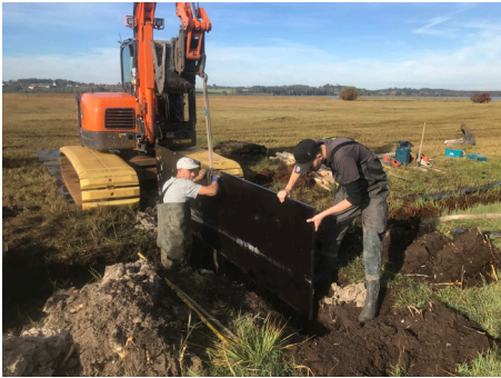
Abb. 8: Einbau Stauplatte für Grabeneinstau (Quelle: @ Xaver Jutz)
