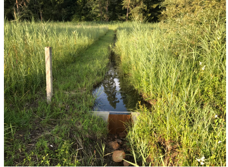
Abb. 9: Eingestauter Graben zur Unterbindung der Moor-Entwässerung (Quelle: @ Xaver Jutz)
