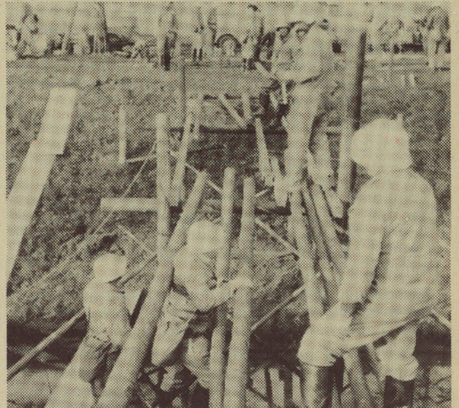
Das viele Bauholz musste erst noch im Übungsgelände Ohrbühl zusammengesucht, antransportiert und fachmännisch zugerichtet werden.
