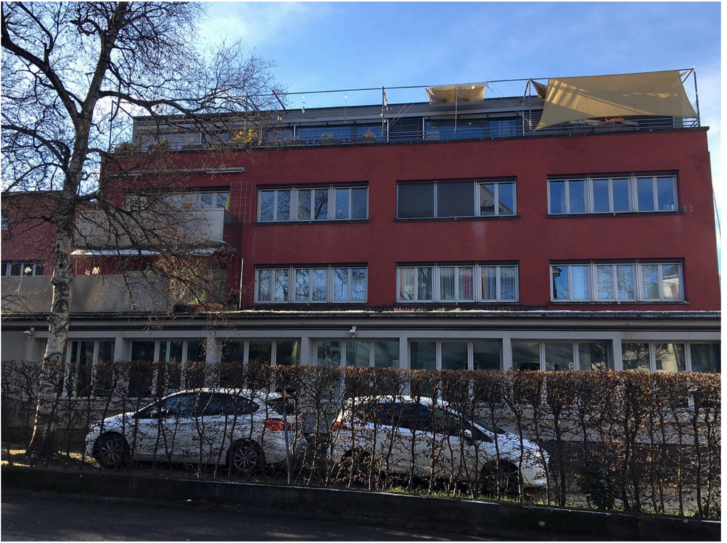
Nidelbadstrasse 6/8. Ehemaliges Fabrikgebäude. Baujahr 1932. Foto: SB (19.1.2023) Heute Wohnkomplex der Stiftung PWG.
